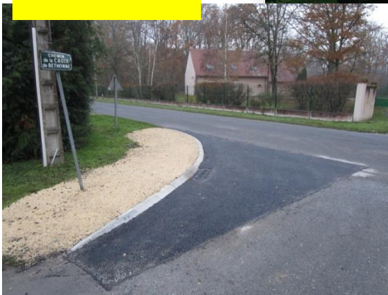
Aménagement Croix de Béthonne : redressement du trottoir et écoulement
