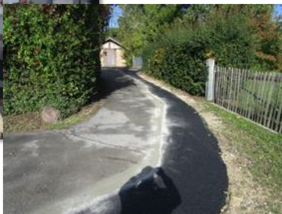
Réfection des enrobés allée du lavoir, route de Vierzon et sur le parking la place de mairie
