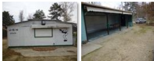
Emplacement de la future dalle béton
