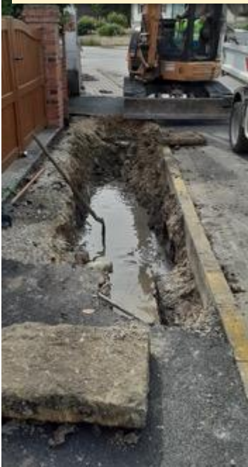
Remplacement du tuyau d'eau pluviale route de Vierzon
